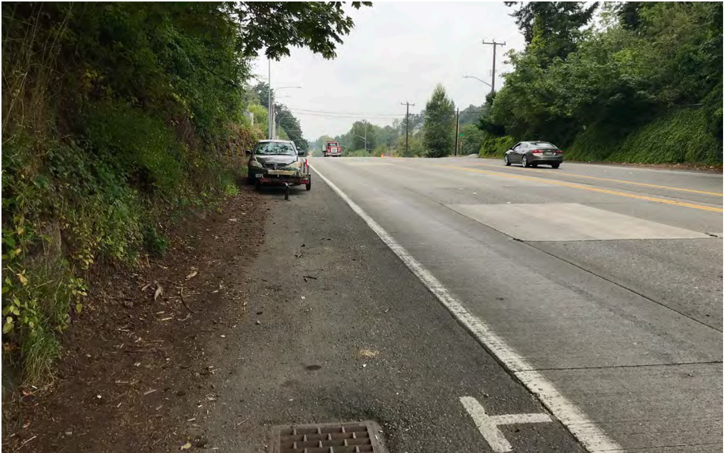
SR 900 với lưu lượng giao thông lớn có vỉa hè hạn chế và thiếu các hạng mục an toàn khác.
